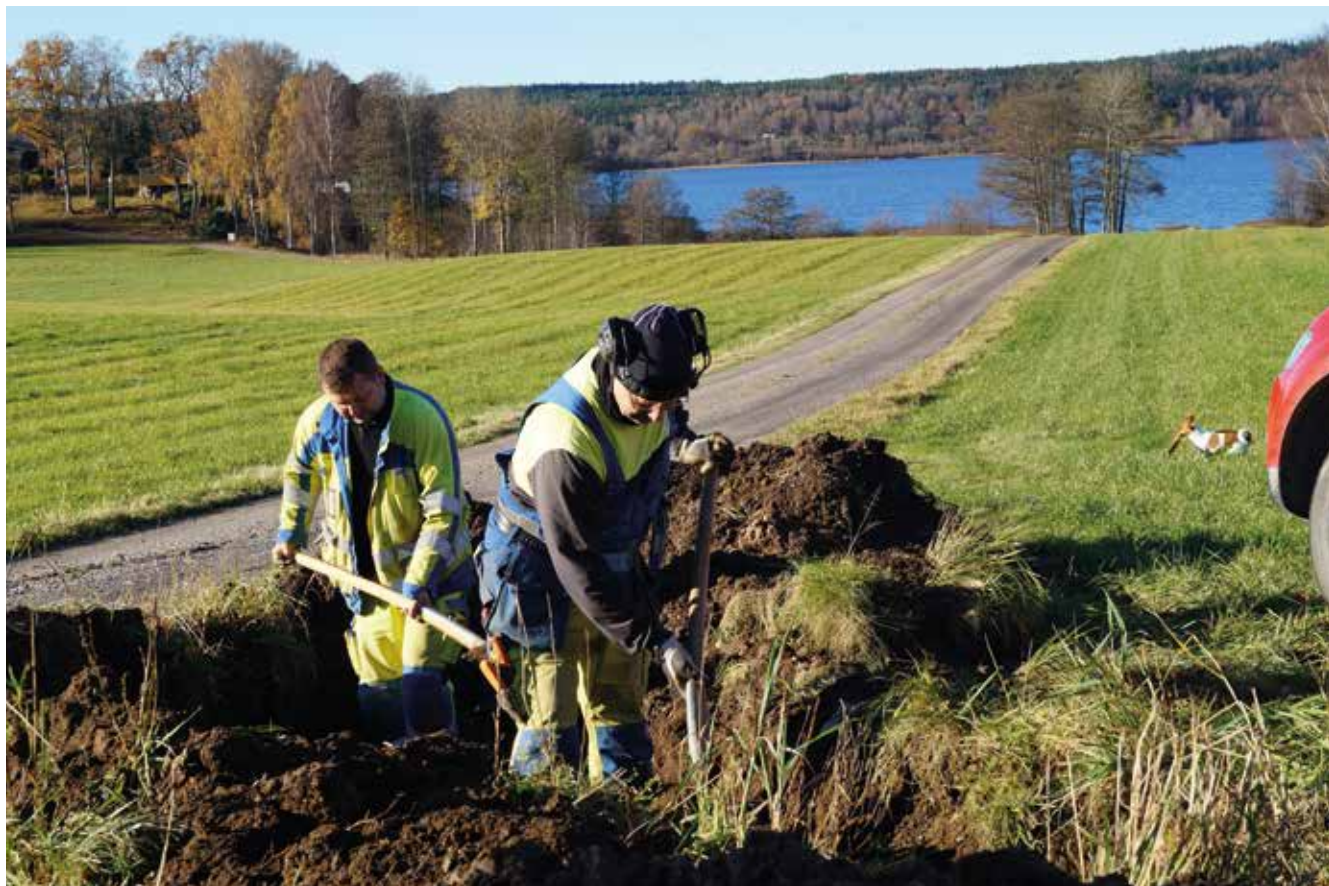
➤ Adde och Thomas förbereder en kabelskarv i Långared med sjön Anten i bakgrunden.
