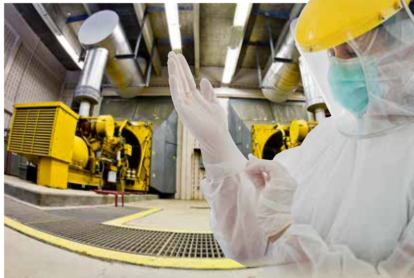
► Reservkraften på exempelvis svenska sjukhus består ofta av diesellaggregat där dieselmotorerna drar igång och producerar el vid ett elavbrott.
